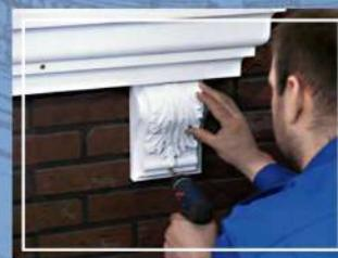
7.6. После монтажа оконного проёма установить замковый камень и кронштейн по месту на клей, закрепить дополнительно шурупами.
