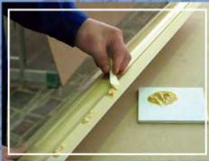
13. Нанести клей АДВ-11 с обратной стороны изделия на поверхности детали, которые будут соприкасаться со стеной и потолком, по всей длине сопряжения.
