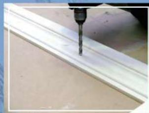
7.2. Разметить места крепления к стене на собранном обрамлении окна и просверлить отверстия под шурупы.
