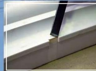
5.3. Вырезать посадочные места замкового камня по разметке.
