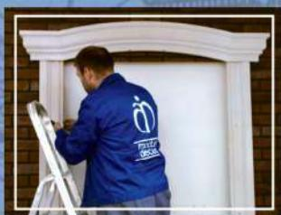
7.5. Приложить обрамление оконного проёма к стене и зафиксировать его шурупами, смазанными клеем АДВ-11.
