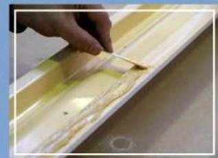
7.4. Нанести клей АДВ-11 (120 гр.) по всему периметру без пропусков, что обеспечит надёжную фиксацию на стене и исключит попадание влаги внутрь профиля деталей.
