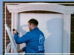
7.3. Приложить собранное обрамление оконного проёма по месту монтажа и через отверстия отметить на стене места для сверления под дюбеля.
