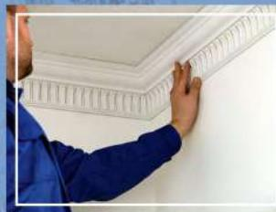
16. Состыковать с уже установленным карнизом или молдингом, выдавливая лишний клей из стыка, максимально притягивая изделия друг к другу. Зафиксировать деталь, как описано в пункте 15, чтобы предотвратить её сползание. Для соединения деталей в углах следует применять клей АДВ-11 (90 гр) или акриловый герметик.
